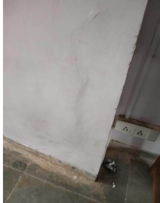
(d) Bulging of the column at second floor
